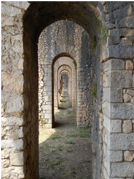
Terracina, boogconstructies in beton
