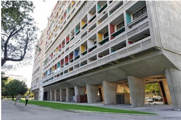
Le Corbusier, Unité d'Habitation, Marseille
